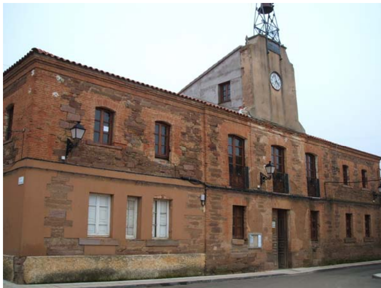
Vista exterior del edificio del Reloj
